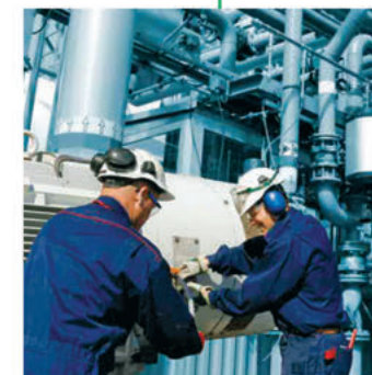
Защита от поломки
